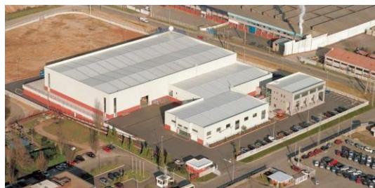
Instalaciones de Cablerías Auto, S.L.; Porriño (Pontevedra)
